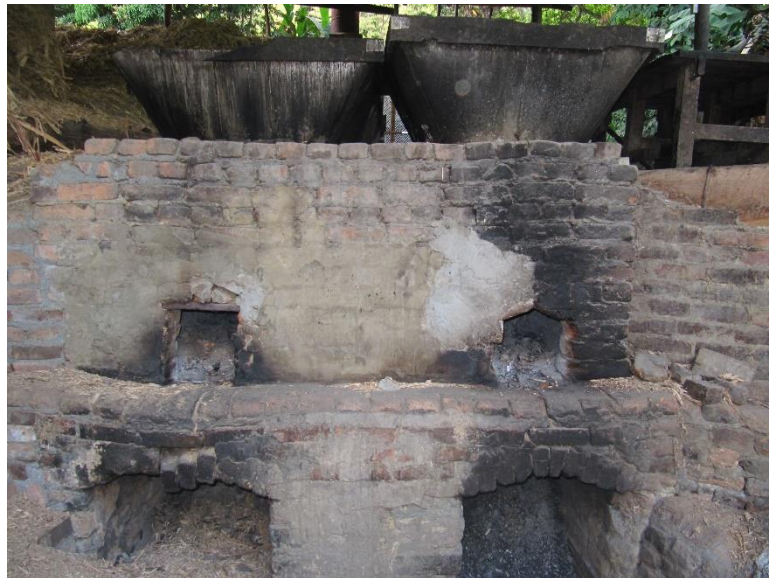
Figura 19. Cámara de combustión trapiche vereda el Zancudo.
