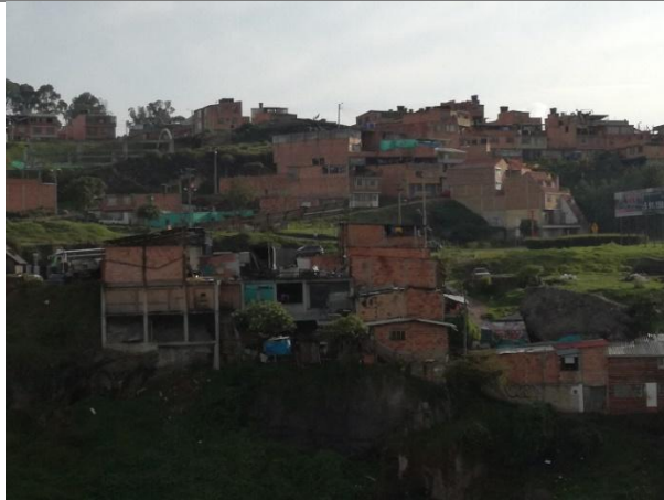
c). Construcción de tugurios en áreas de riesgo.
