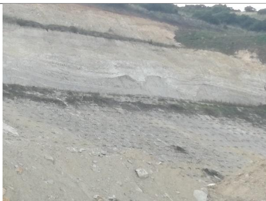
(a). Siembra tipo cespedon en forma de ajedrez
