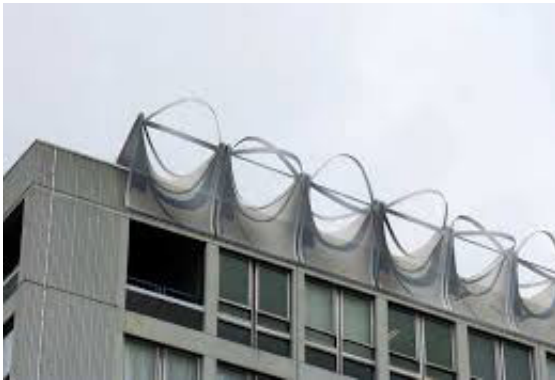
Figura 2. Turbina Crossflex. Se observa una aplicación dentro de un entorno urbano.
