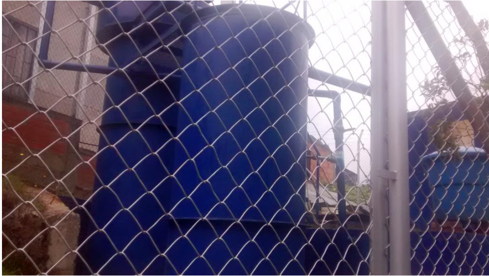
Anexo 3. Acueducto de la vereda la tribuna, fotografía tomada el día de la entrevista
