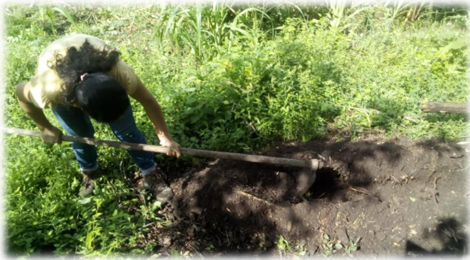
Ilustración 7 realización de huecos
