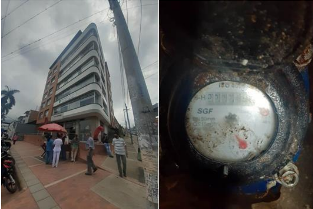
Gráfica 24. Visita al edificio EXCEDRA, calle 18 n° 11 – 116.
