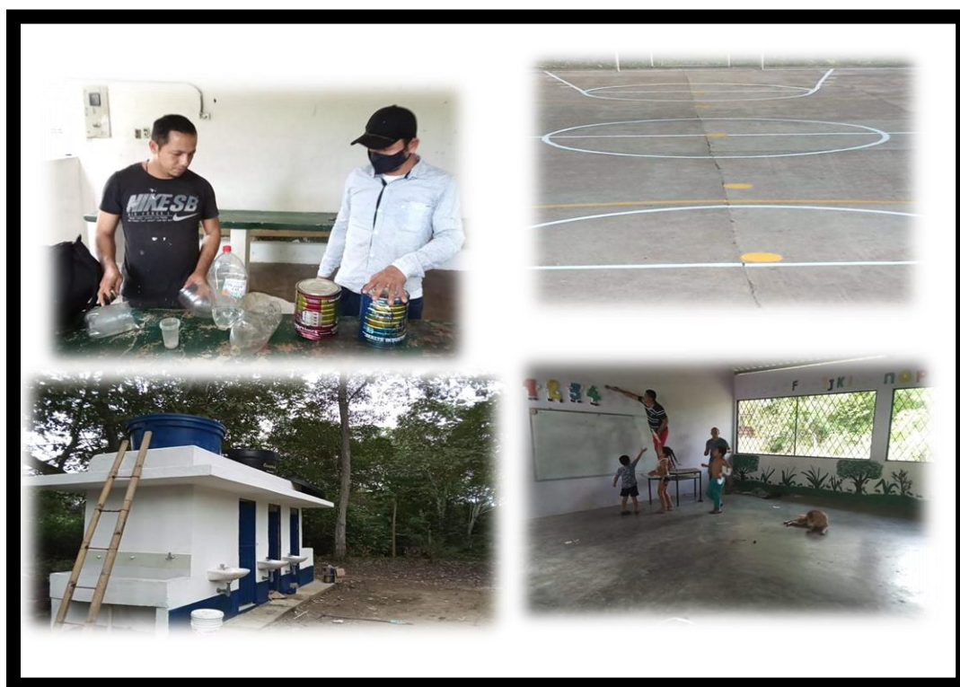
Ilustración 10 Remodelación baños y salones
