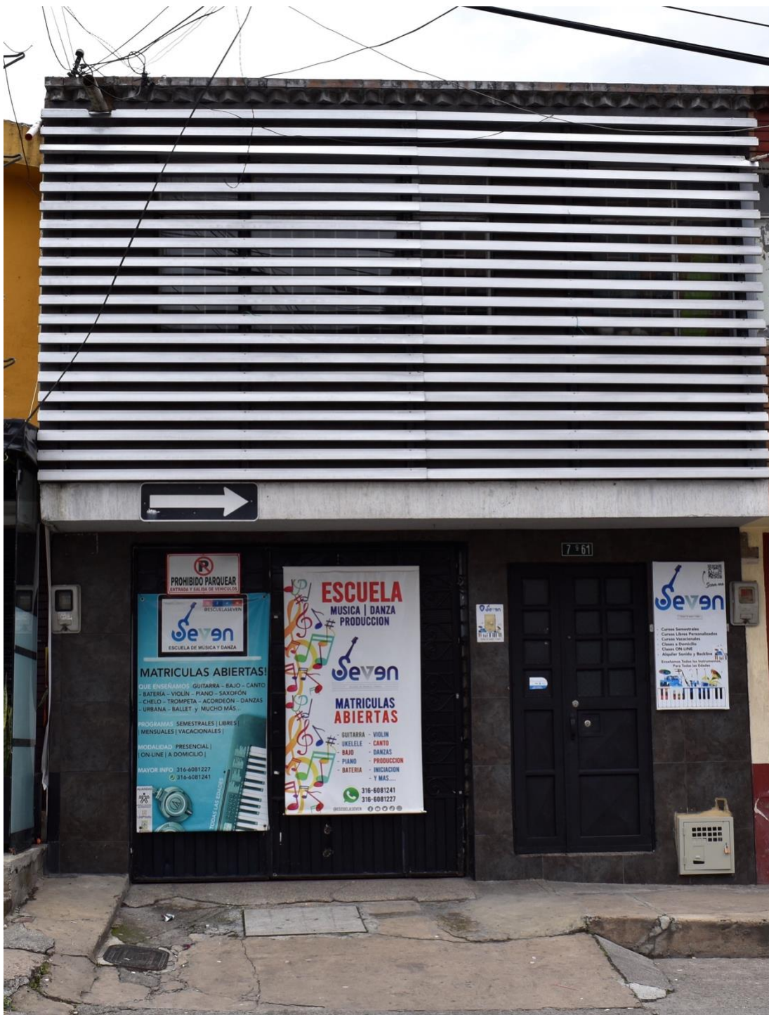
Imagen Fachada instalaciones Escuela Seven (Imagen propia)
