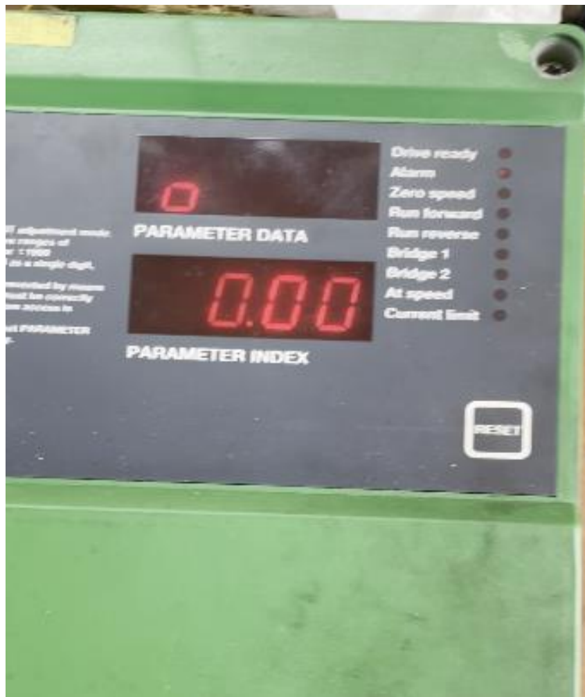
Figura 37. Prueba de encendido del drive Mentor II.
